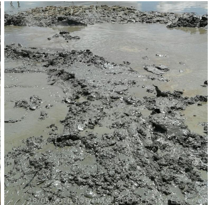
Fig D: Backfill
